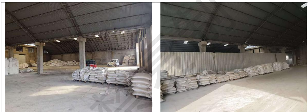
图2-4 厂房现状情况
